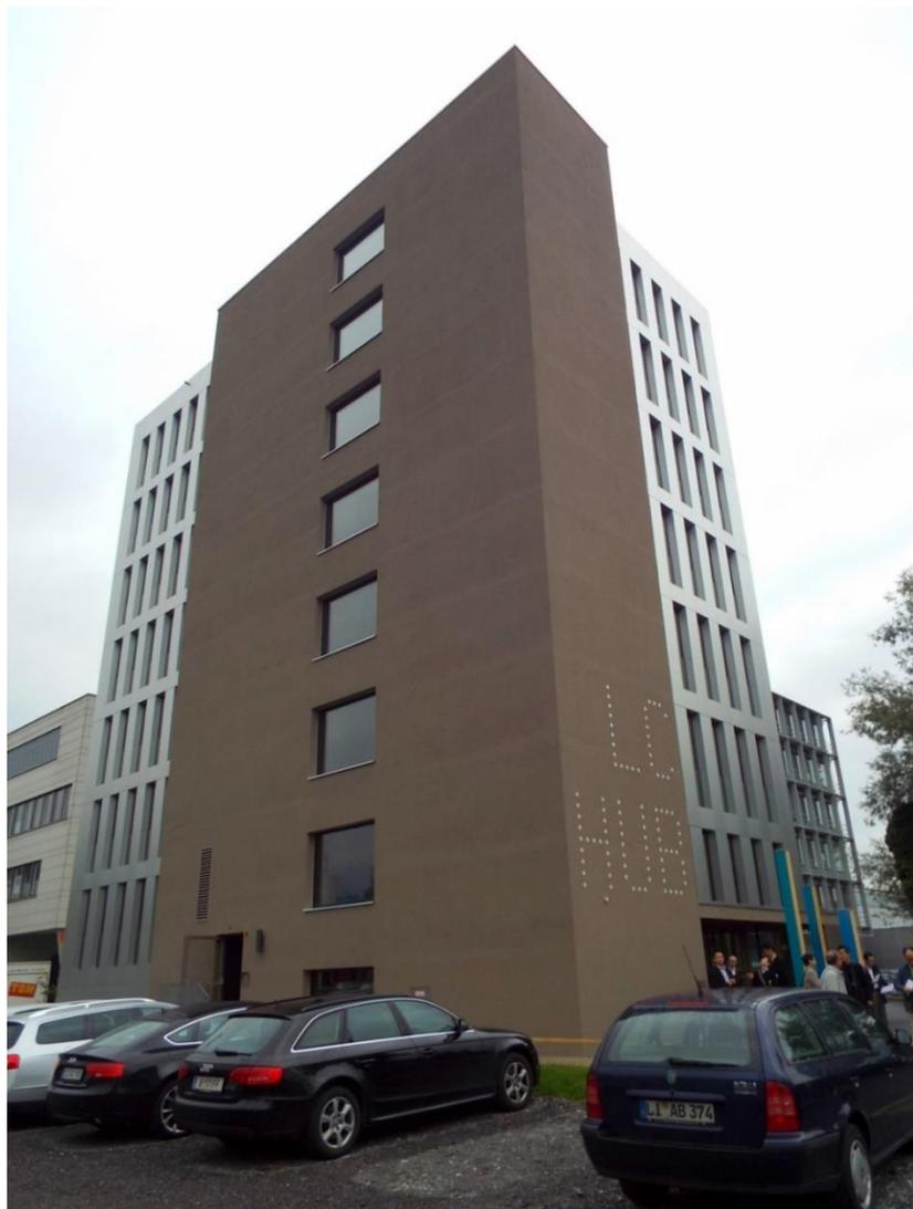
オーストリア西端に近いドルンビルンにある8階建て事務所（この建物の構法を開発したコンサルティング会社C R E E社）の木造ビルです。建設時、使用時、解体時のライフサイクルエネルギーを意識してライフサイクルタワーと命名されています。
